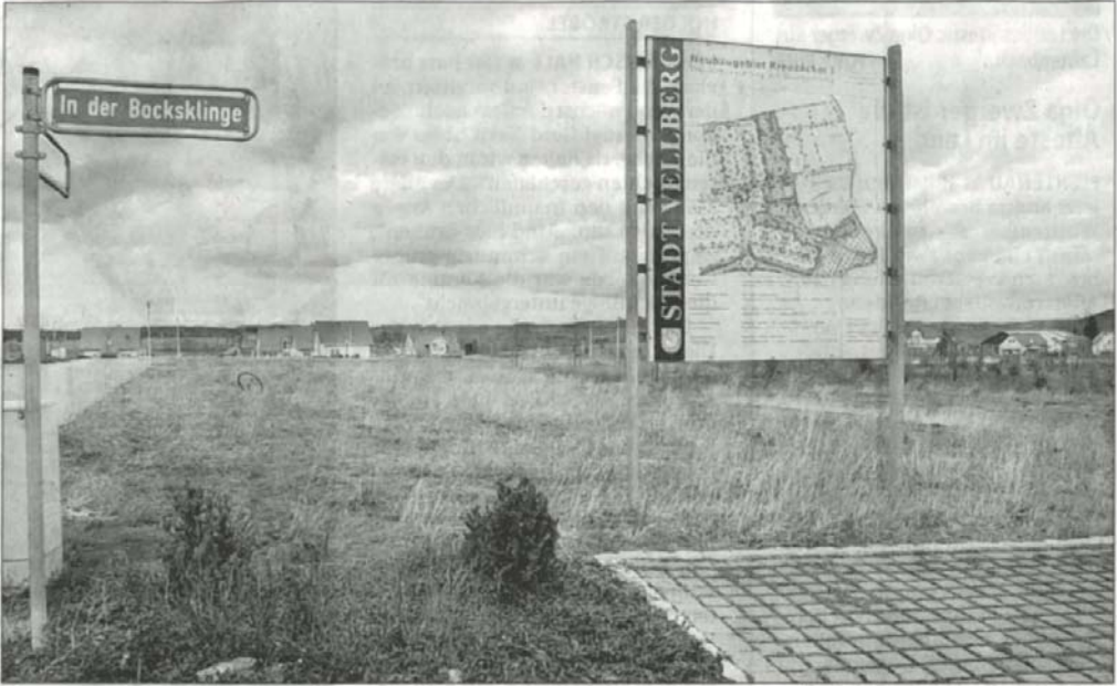
Über ein großes Baugebiet, in dem seit Jahren kaum Häuser, dafür um so mehr Gras in die Höhe wächst, verfügt die Stadt Vellberg mit den „Kreuzäckern“. Anderen Kommunen droht das selbe Schicksal, warnen die Fachleute. FOTO: ARSLAN
